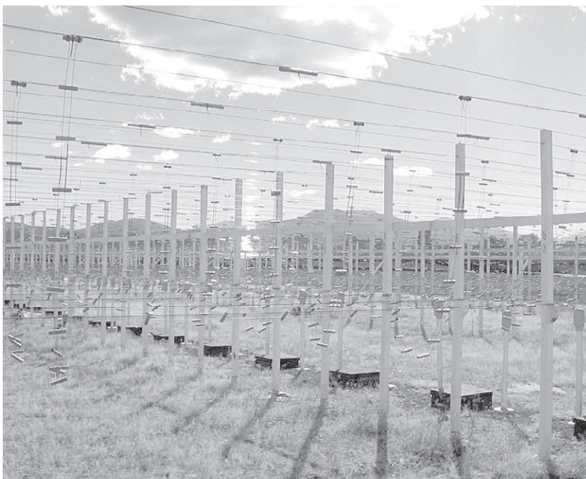
La antena del MEXART consiste en un arreglo de 4096 (64x64) antenas (tipo dipolo) cubriendo un área física total de 9500 metros cuadrados. En la dirección este-oeste el arreglo tiene una longitud de 140 metros y en la dirección norte-sur el arreglo mide 80 metros. Los componentes básicas de un radiotelescopio son: la antena, los amplificadores, la matriz de Butler y los receptores, de donde finalmente se capta la señal de la antena digitalmente en una computadora y los datos se envían a través de Internet. A diferencia de un radiotelescopio parabólico, el arreglo de antenas del MEXART es un instrumento de tránsito, sus haces (direcciones en el espacio hacia donde capta señales la antena) apuntan a diferentes direcciones fijas en el plano norte-sur. Al moverse el radiotelescopio con la Tierra, se hace un continuo escaneo del cielo donde ocurre el tránsito de las fuentes de radio cósmicas. Fuente: http://www.mexart.unam.mx
