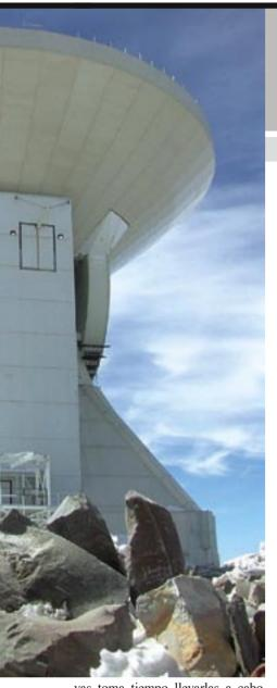
un reflector secundario que registra microondas en el rango de 60 a 340 GHz (frecuencias de radio), capaz de apuntar con una precisión cercana a 1 segundo de arco, es decir, un ángulo menor al que abarca la Luna llana.
